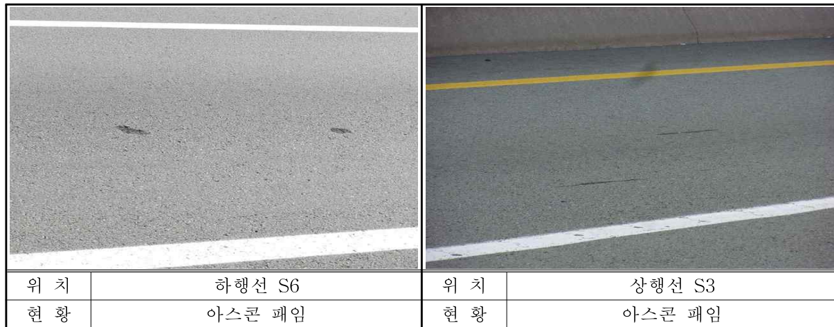
[표 2.1.8] 교면포장 외관상태
